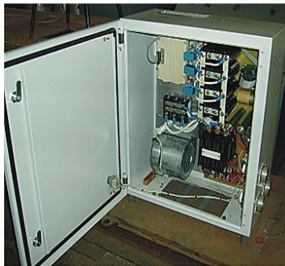
Шкаф преобразователей для вспомогательного электрооборудования
