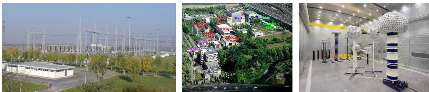
Испытательный центр CESI
