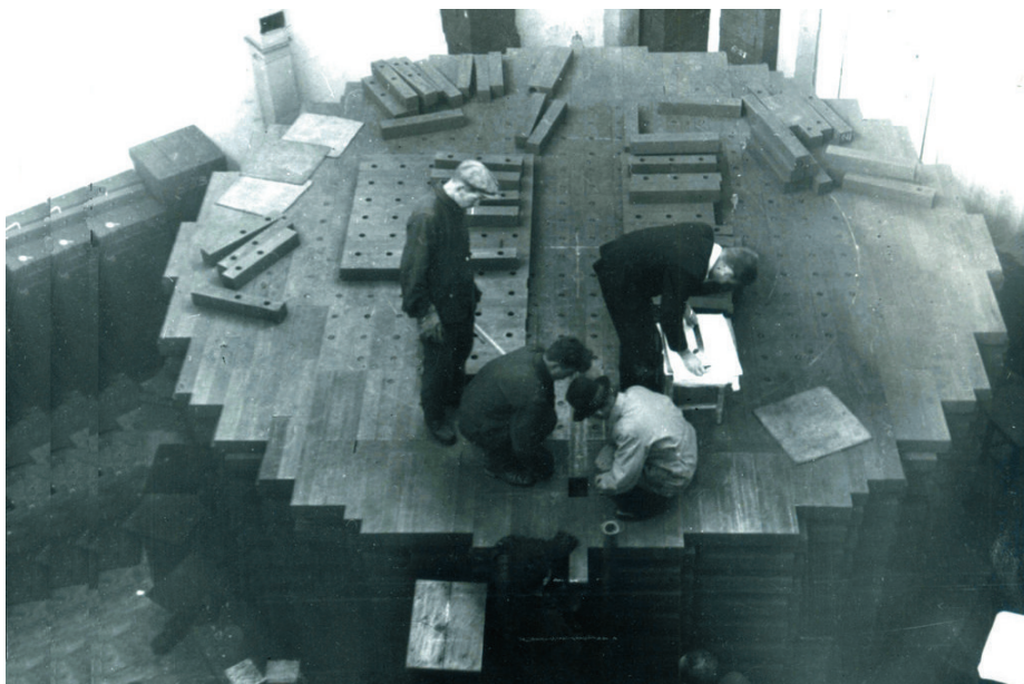
Монтаж реактора Ф-1
